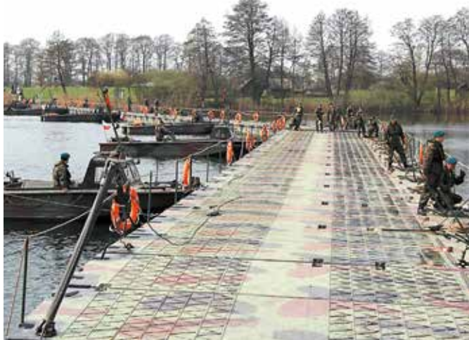
Ostrow Lednicki łączenie mostu pontonowego PP-64. (Źródło: 2.pinż)
