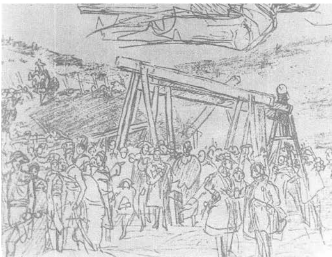
Przygotowania do budowy przeprawy rzecznej
