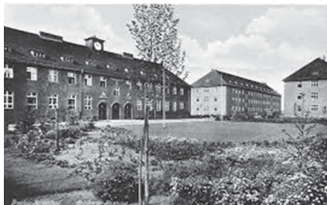
Fragment kompleksu koszarowego Oddziału Artylerii Przeciwpancernej 28 Dywizji Piechoty /część północna/ - budynek nr 2 kuchni i stołówki żołnierskiej oraz budynki koszarowe nr 1 i nr 4. Kalenica dachu budynku kuchni zwieńczona charakterystyczną kopułką z zegarem /zaginął w niewyjaśnionych okolicznościach podczas remontu w 2010 roku/. Nad portalami drzwi wejściowych reliefy o tematyce kwatermistrzowskiej. /1936 r./
