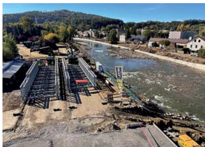
Montaż konstrukcji przęsłowej na placu montażowym – Głuchołazy
