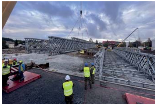
Transport poziomy mostów DMS-65 na przyczółki za pomocą dźwigu 500 Mg – Głuchołazy
