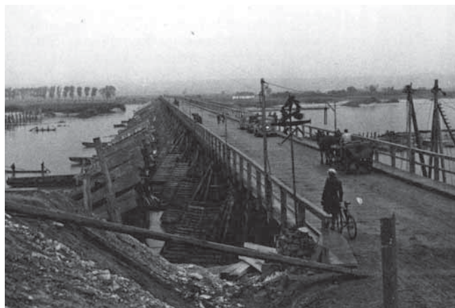
Drewniany most na Wiśle pod Annopolem.
