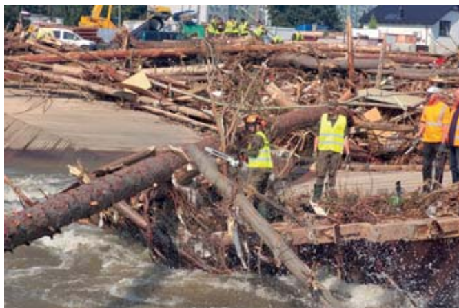
Usuwanie zalegających w korycie rzeki pozostałości popowodziowych – Głuchołazy
