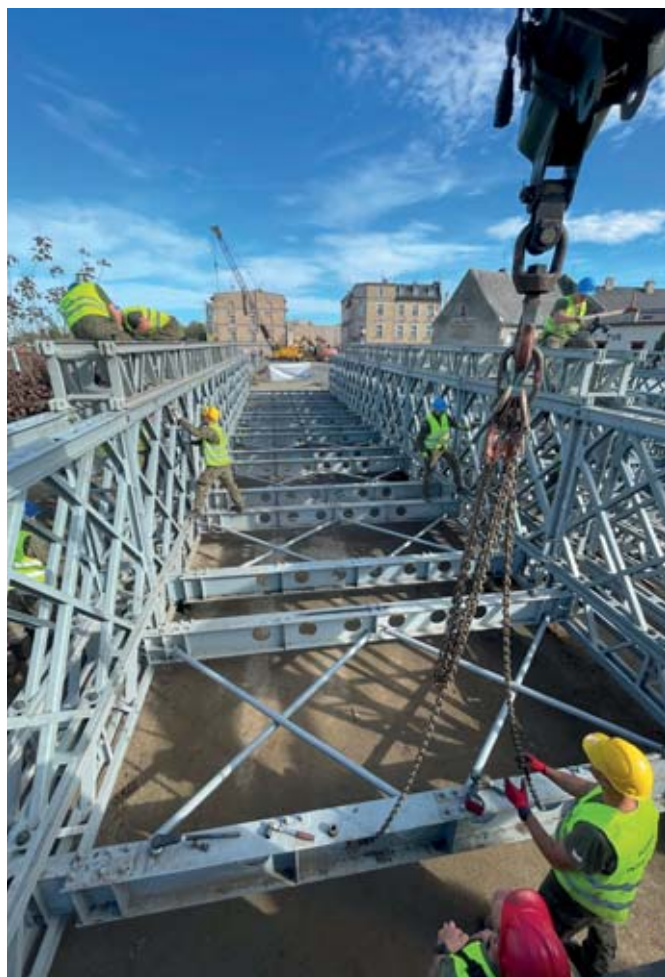
Montaż konstrukcji przęsłowej na placu montażowym – Głuchołazy
