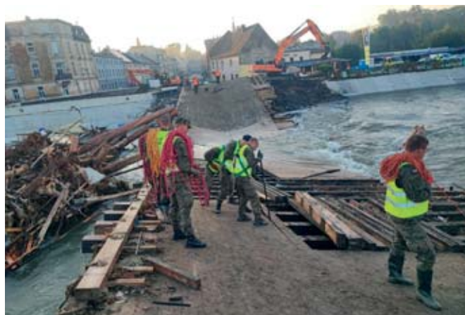
Demontaż pokładu drewnianego zniszczonego mostu – Głuchołazy
