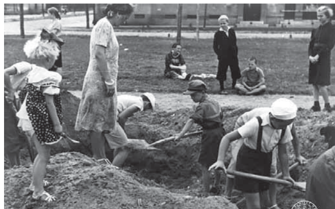
Budowa umocnień polowych w Warszawie
